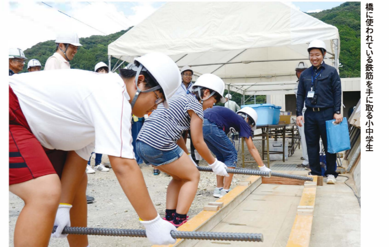
午後からは同市津島町若松で老朽化した幅約4.5mの橋を、歩道付きで幅約10mの橋に架け替える県道改良工事を見学。橋脚建設を担う一若建設(同市)の須田健司さん(63)から橋脚1本にコンクリート約千立方メートル、鉄筋約124トンが使われていると教わり、くいの打設位置をパソコンで確認する精度管理システムも見学した。
